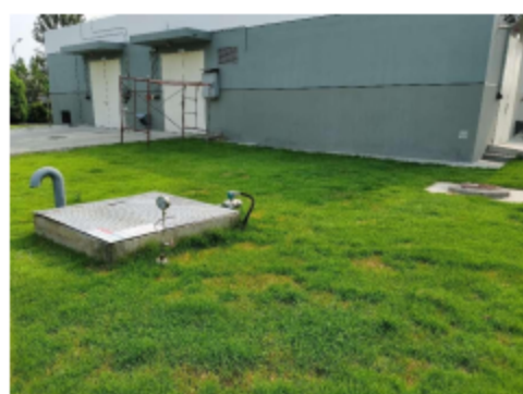
危险品库、新危废间收集池
